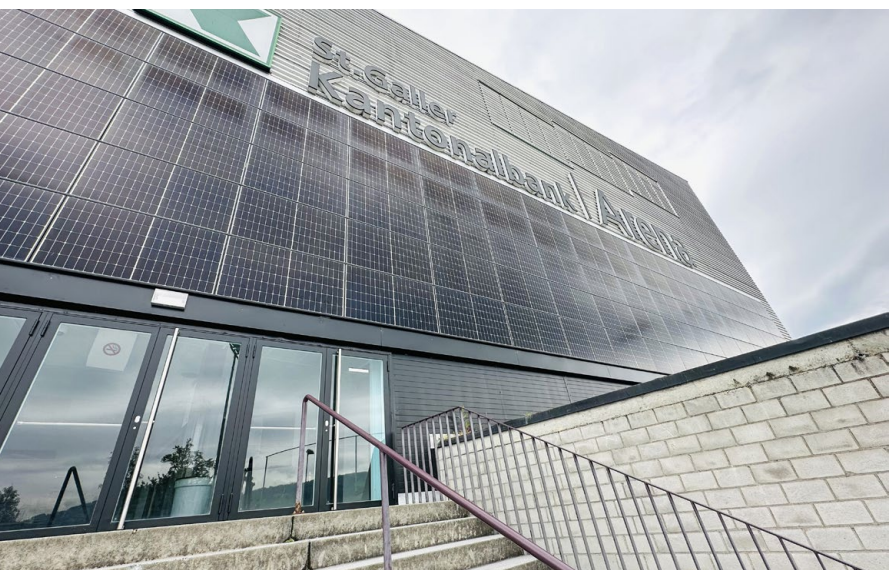
Städtische Gebäude werden zurzeit wenn immer möglich mit Fotovoltaik-Anlagen ausgerüstet. Unlängst wurde die seeseitige Fassade der St. Galler Kantonbank Arena mit Panels versehen.
