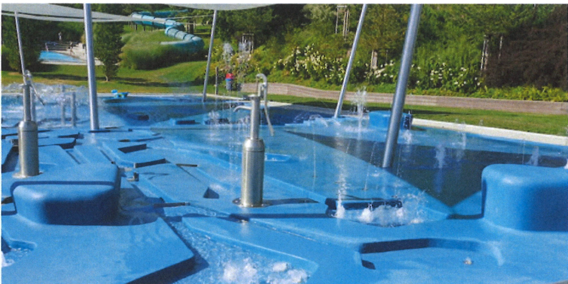
Freibad Heuried, Beckenlandschaft in Beton und Beschichtung
