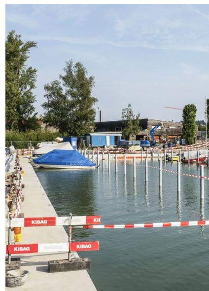
Die Hafenanlage im Lido ist in die Jahre gekommen. Zustandsaufnahmen aus dem Jahr 2014 haben ergeben, dass sie sich mehrheitlich in einem schadhafte Zustand befindet und instand gesetzt werden muss. Seit Anfang dieses Jahres sind die Sanierungsarbeiten in vollem Gang. Sämtliche Ufermauern werden erneuert, ihr Verlauf wird teilweise leicht angepasst. Für die Mauern werden Spundwände in den Boden getrieben und anschliessend mit dem Bagger Fertigbetonelemente als sogenannte Mauerkrone aufgesetzt.
