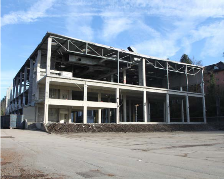
Mit dem Rückbau des alten Fabrikgebäudes entsteht auf dem ehemaligen Areal der Petroplast Vinora AG Raum für Neues. (Bild: Istvan Nagy)
