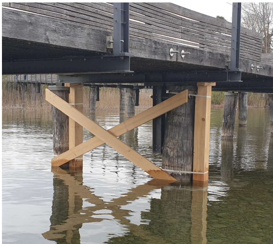
Abbildung 4: Unterstützungsmassnahmen bei nicht mehr tragfähigen Pfählen
