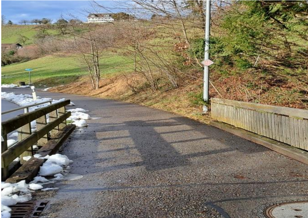
Ersatz Brücke Hombrechtikerstasse
