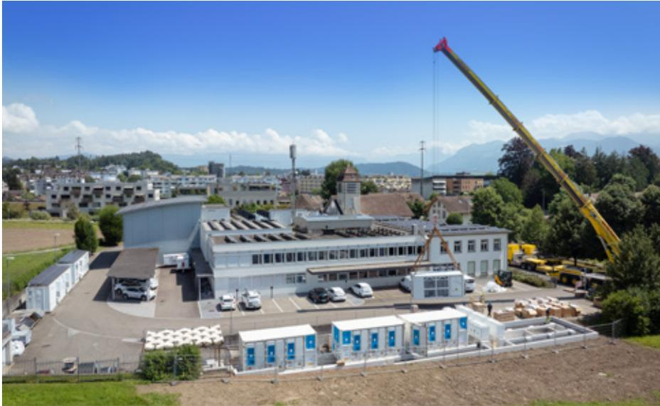
Mit dem Schwerlast-Mobilkran werden die Batteriespeicher vor dem EWJR aufgestellt. (Bild: Manuela Matt)
