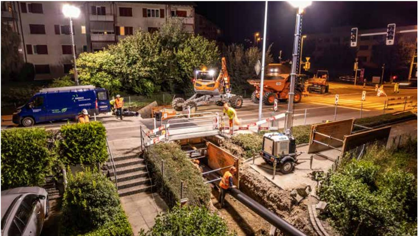
An der St. Gallerstrasse werden Fernwärmeleitungen verlegt – und das ist erst der Anfang. Bis 2036 soll das Fernwärmenetz fast die ganze Stadt umfassen.
