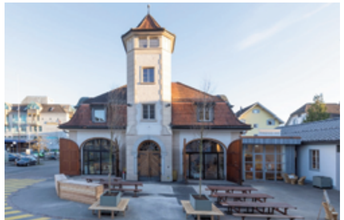
Altes Feuerwehrdepot in neuer Funktion
