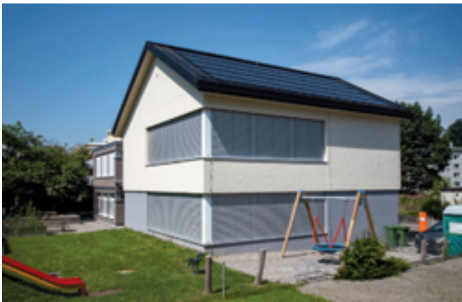
Kindergarten Rain; Fotovoltaikanlage und neuer Anbau Gruppenräume
