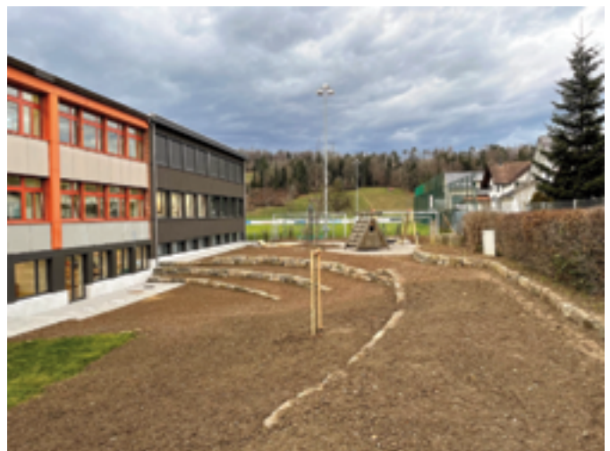
Schulanlage Wagen; Schulhauserweiterung mit Umgebungsgestaltung
