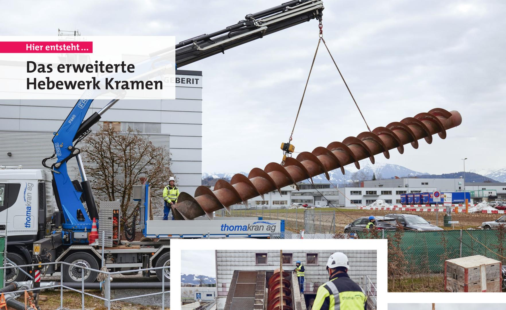
Am Hebewerk Kramen der Abwasserreinigungsanlage (ARA) Rapperswil-Jona fliessen mehrere Abwasserstränge von Norden und Osten zusammen. Der Trockenwetterteil des Abwassers wird über zwei Förderschnecken zur ARA geleitet. Bei Regenwasser fliesst das zusätzlich anfallende Mischwasser über eine Entlastungsförderschnecke in das Regenüberlaufbecken Stampfstrasse.
