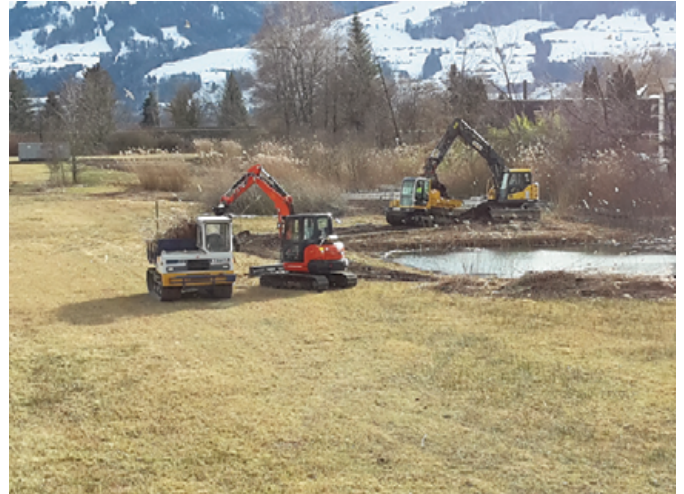
Bei den Arbeiten wurden Raupendumper und Bagger mit speziell breiten Raupenfahrwerken eingesetzt, um möglichst bodenschonend zu arbeiten.
